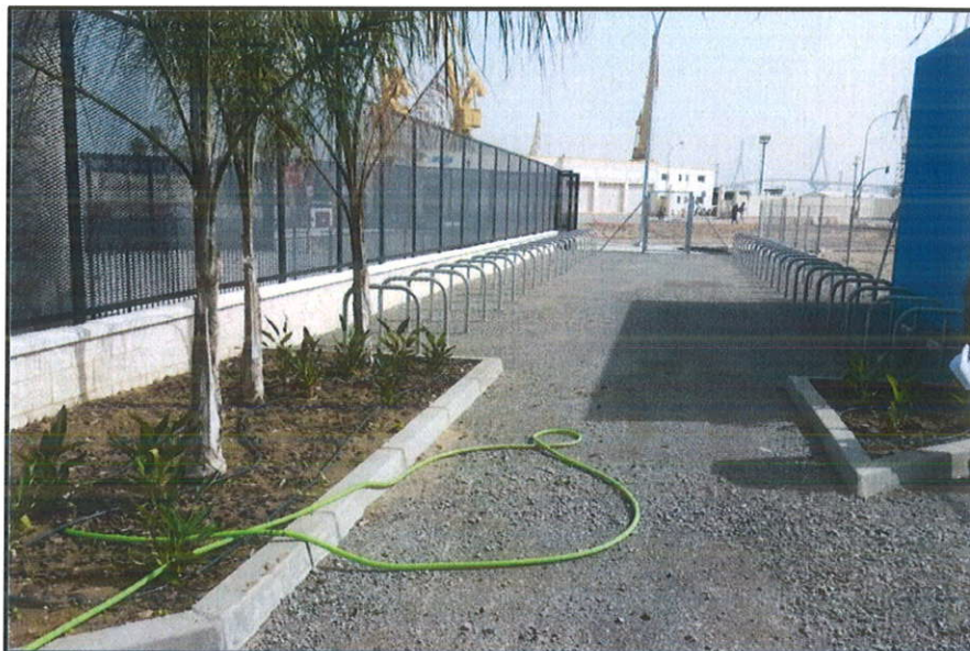
Imagen 1. Vista recinto del aparcamiento de bicicletas
